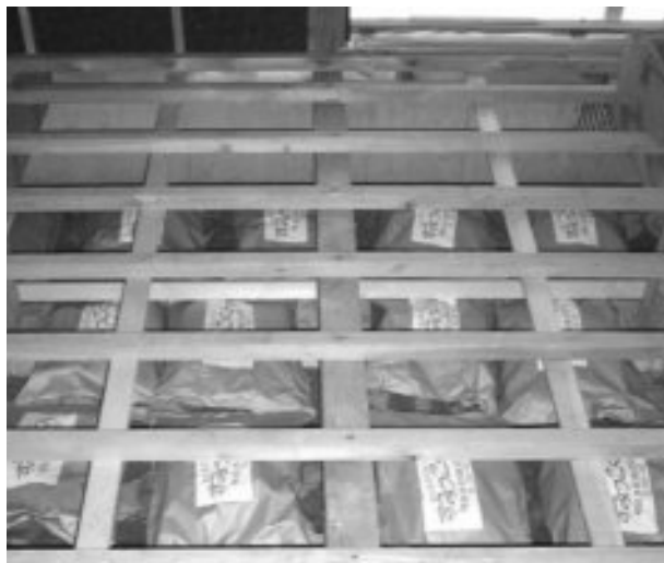
すみっくん」床下施工例
